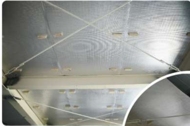
鐵皮屋改善工程
